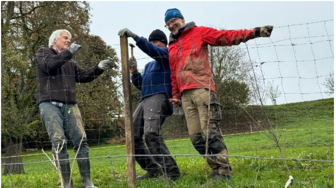
Das Anbringen eines Wildschutzzauns ist unabdingbar, um die Jungpflanzen vor Wildschätzen schützen zu können. Der Zaun wird nach 4 – 5 Jahren entfernt – dann kann die Hecke ihre volle Wirkung als Schutz- und Rückzugsort anbieten. Foto: 26. Okt. 24, Erich Gmünder
